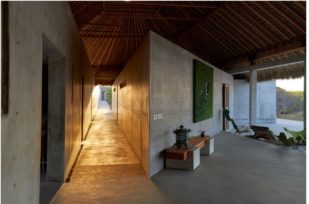
Fig. 4: Vista da parte interna da edificação principal. O telhado é descolado da viga e pilares de concreto. Fonte: Sergio López, 2019. Disponível em: https://www.sergiolopez.mx/houses/casa-wabi . Acesso em: 02 mai. 2021.
