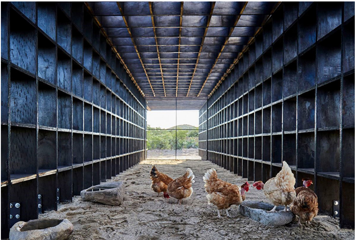
Fig. 10: Vista interna do pavilhão de Kengo Kuma. Fonte: Sergio López, 2019. Disponível em: https://kkaa.co.jp/works/architecture/chicken-coop/ . Acesso em: 04 mar. 2021.
