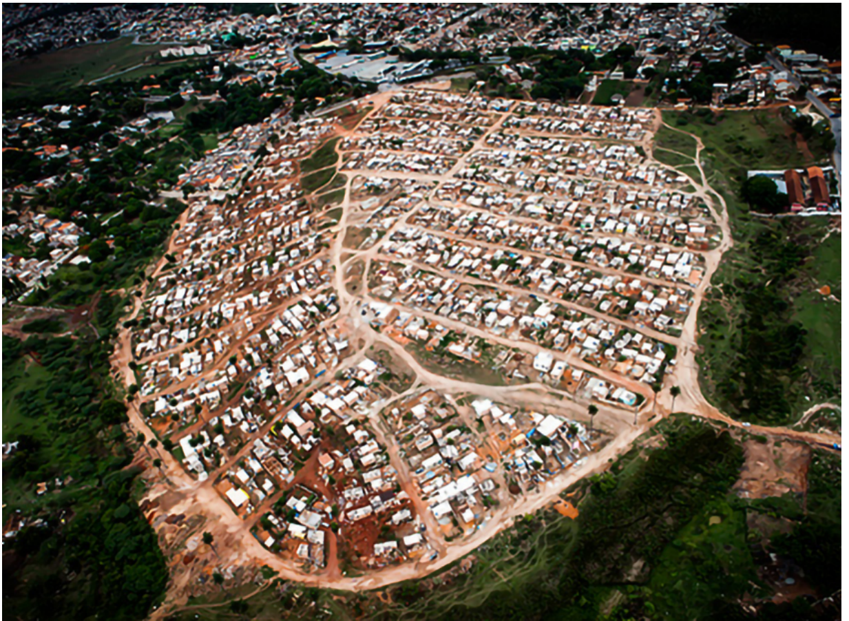
Fig. 2: Dandara Occupation, 2011. Source: COAU Archive, 2011. Available at: https://www.coau.com.br/portfolio/comunidade-dandara/ . Accessed 8 May 2021
