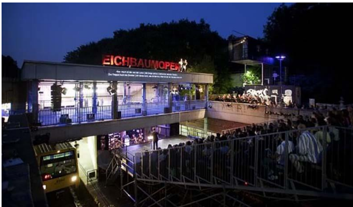
Fig. 2: A estação de metrô adaptada para funcionar como palco para óperas: uma arquibancada e um pequeno conjunto de contêineres foram as intervenções construídas necessárias. Fonte: Rainer Schlautmann, 2009 (LIESEGANG; RICK, s.d.).
