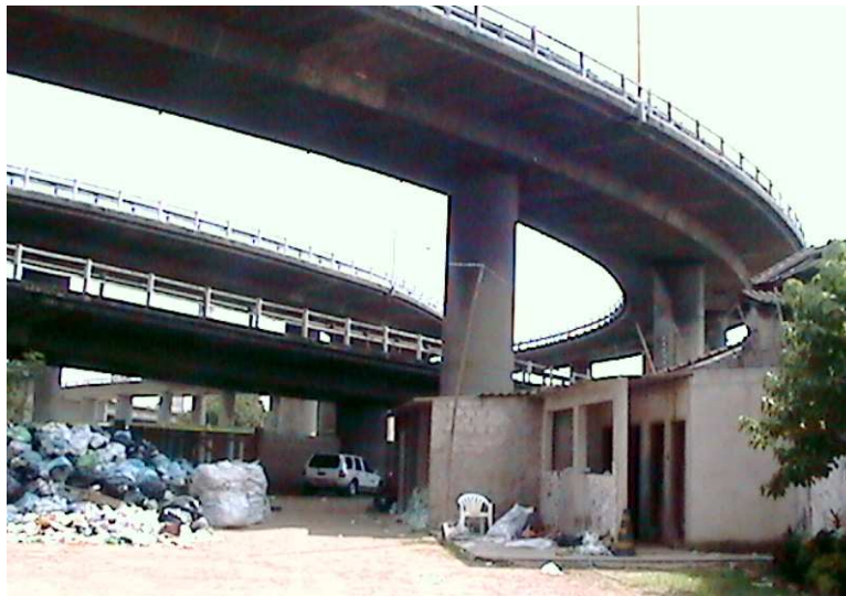
Figura 5: Vista sob o viaduto com os pequenos volumes, galpão do Profetas da Ecologia. Foto Fernando Fuão.
