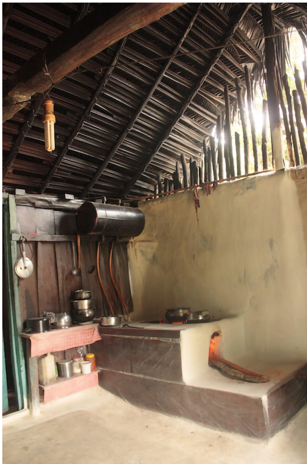
Fig. 5: Fornalha e chão barreado. Fonte: Cerqueira, 2019.
