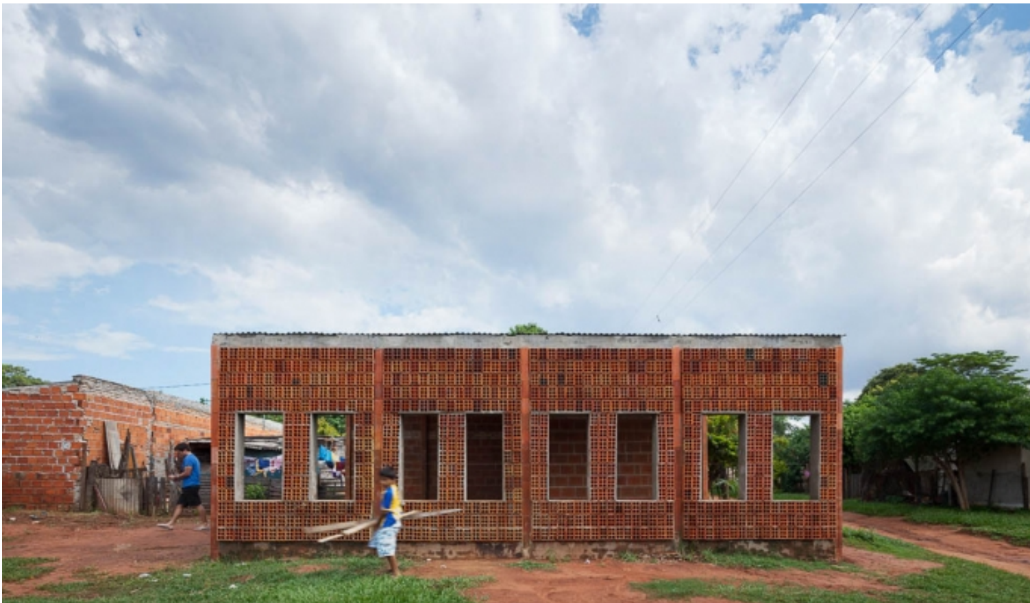
Fig. 2: Centro de Desenvolvimento Comunitário, OCA + Bonini Arquitectos, Luque, Paraguai, 2014. Fonte: Federico Cairoli, 2015. Disponível em: http://www.federicocairoli.com/works/-centro-de-desarrollo-comunitario/ . Acesso em 27/10/2022.
