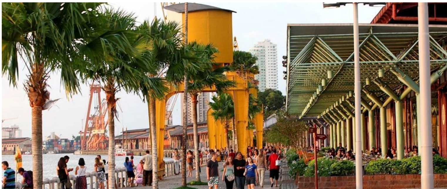
Fig. 2: Intervenção na Estação das Docas. Fonte: Pará Turismo, 2000. Disponível em: http://www.paraturismo.pa.gov.br/vejamaismercadosociais/ociosociais/eventos/belem/estacao . Acesso: 04 nov. 2022.
