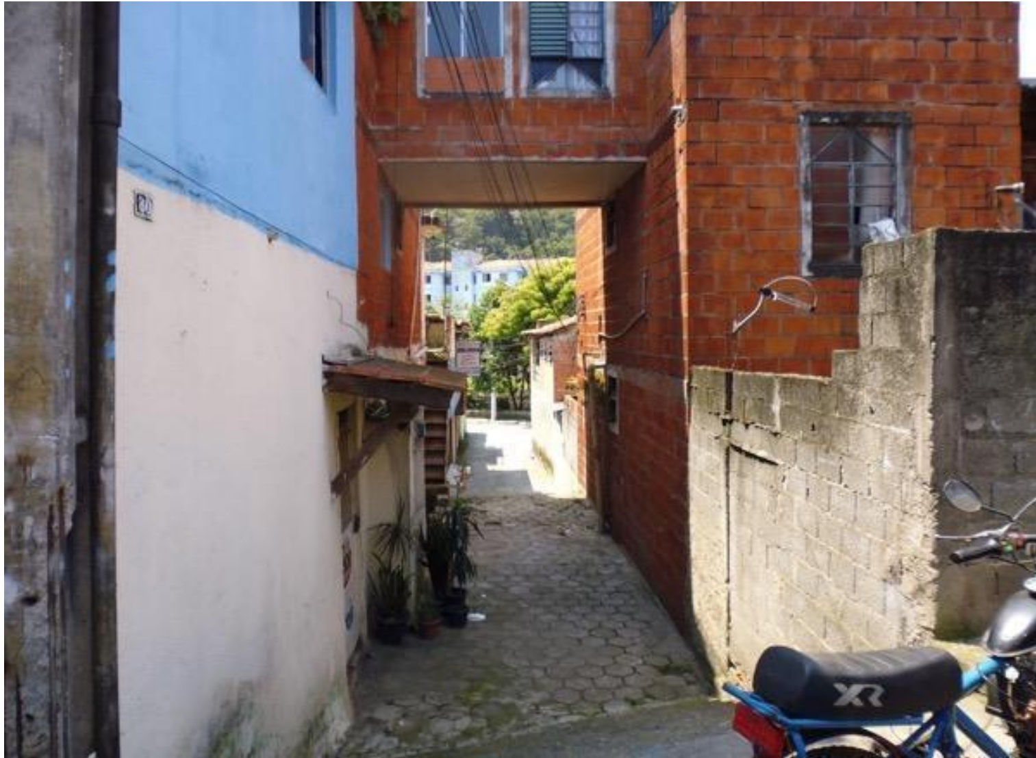
Fig. 9: Passagem. Fonte: Rosa, 2021.
