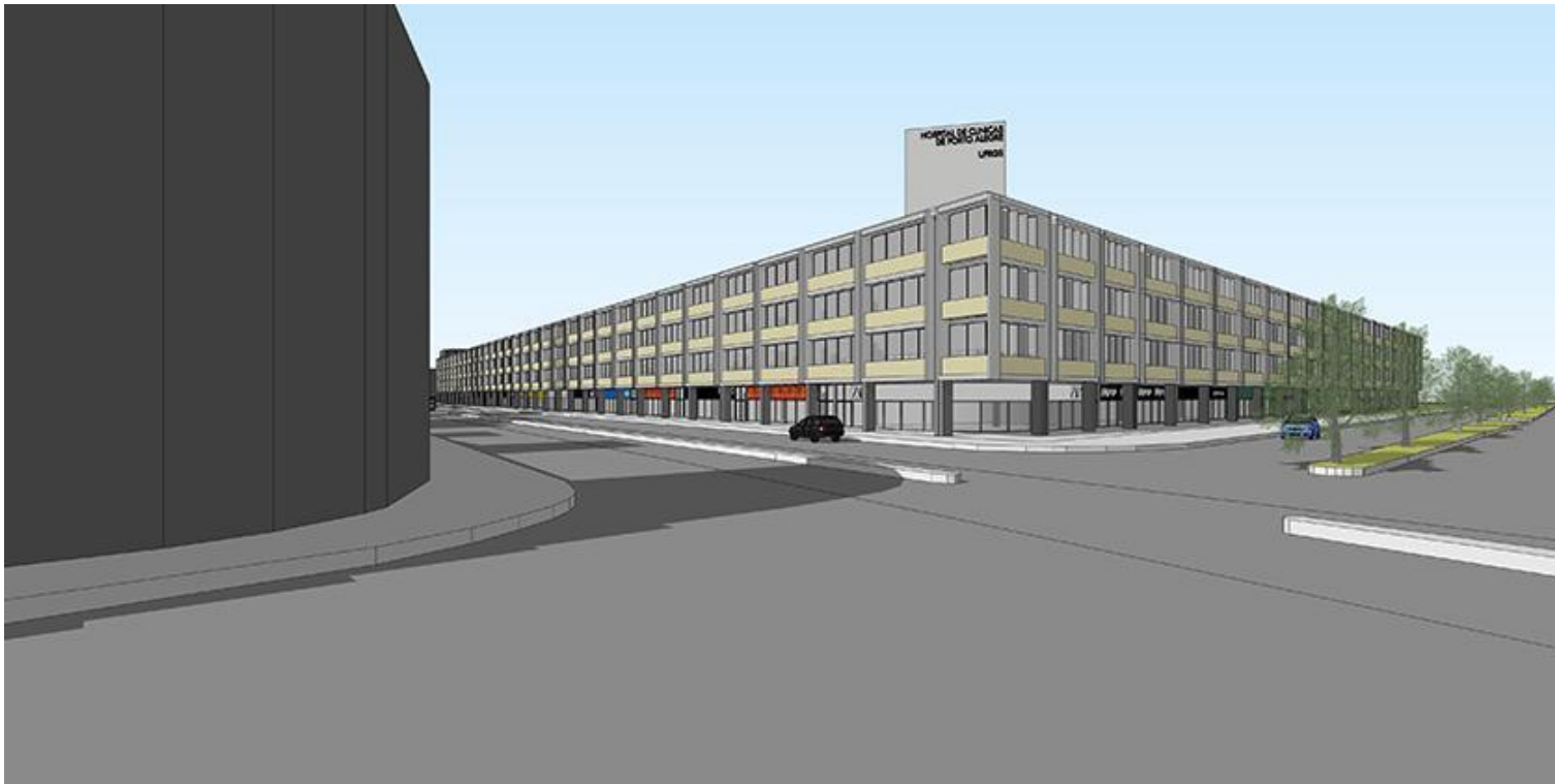
Fig. 18: Hospital de Clínicas de Porto Alegre, projeto alternativo. Vista da esquina da Av. Protásio Alves com Ramiro Barcelos. Fonte: Autor, 2020.
