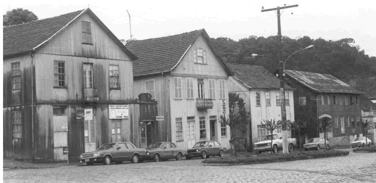
Fig. 3: Conjunto arquitetônico e urbanístico de Antônio Prado, tombado em 1990. Fonte: Arquivo IPHAN-RS, 1984.
