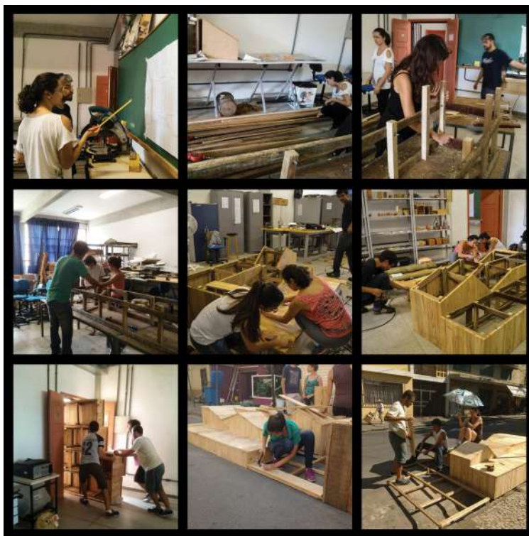
Fig.9 : Processo de construção. Fonte: Acervo dos autores.
