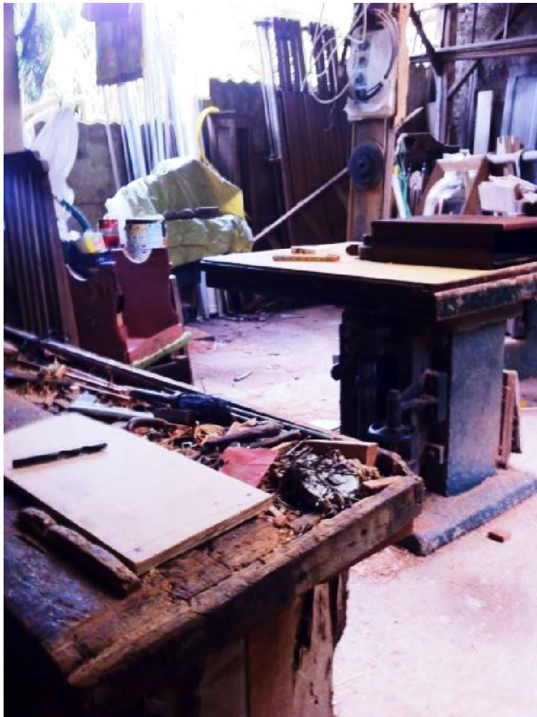
Fig. 1: Confeção do balanço em madeira. Fonte: Acervo pessoal dos autores.
