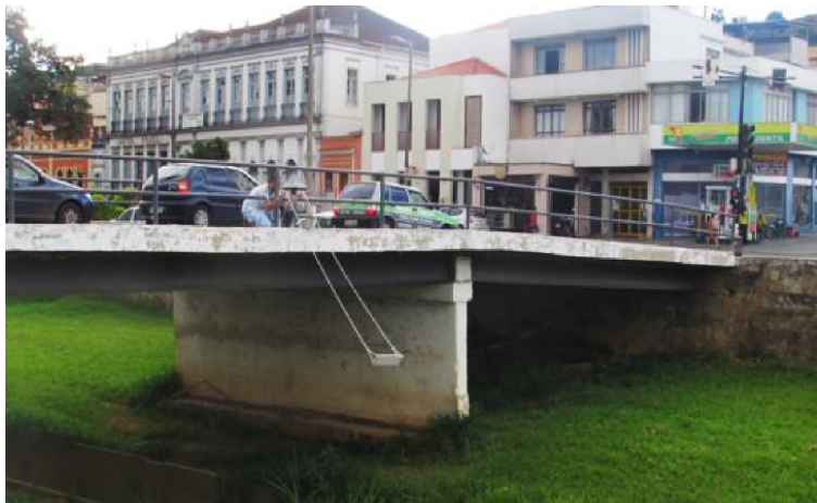
Fig. 10: Balanço instalado e em movimento na ponte da Estação. Fonte: Acervo pessoal dos autores.
