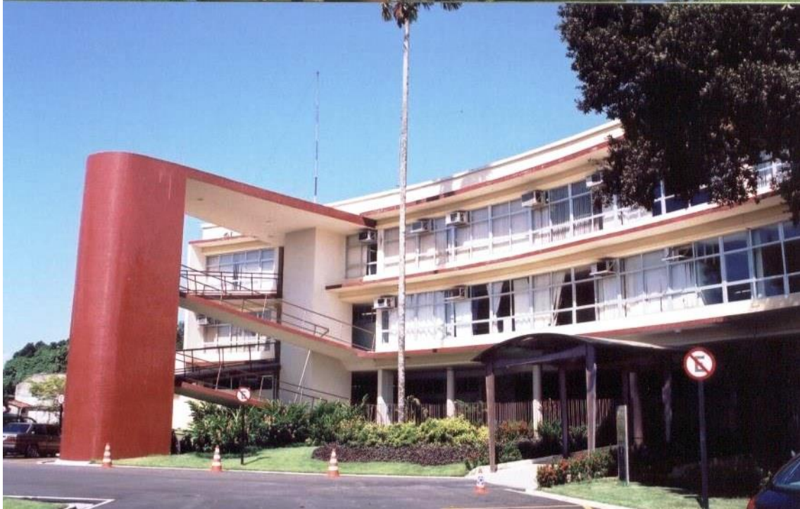
Fig. 14: Edifício Affonso Freire, 1949 (Sede da SETRAN, antigo DER). Camilo Porto de Oliveira. Fonte: Chaves (2006).
