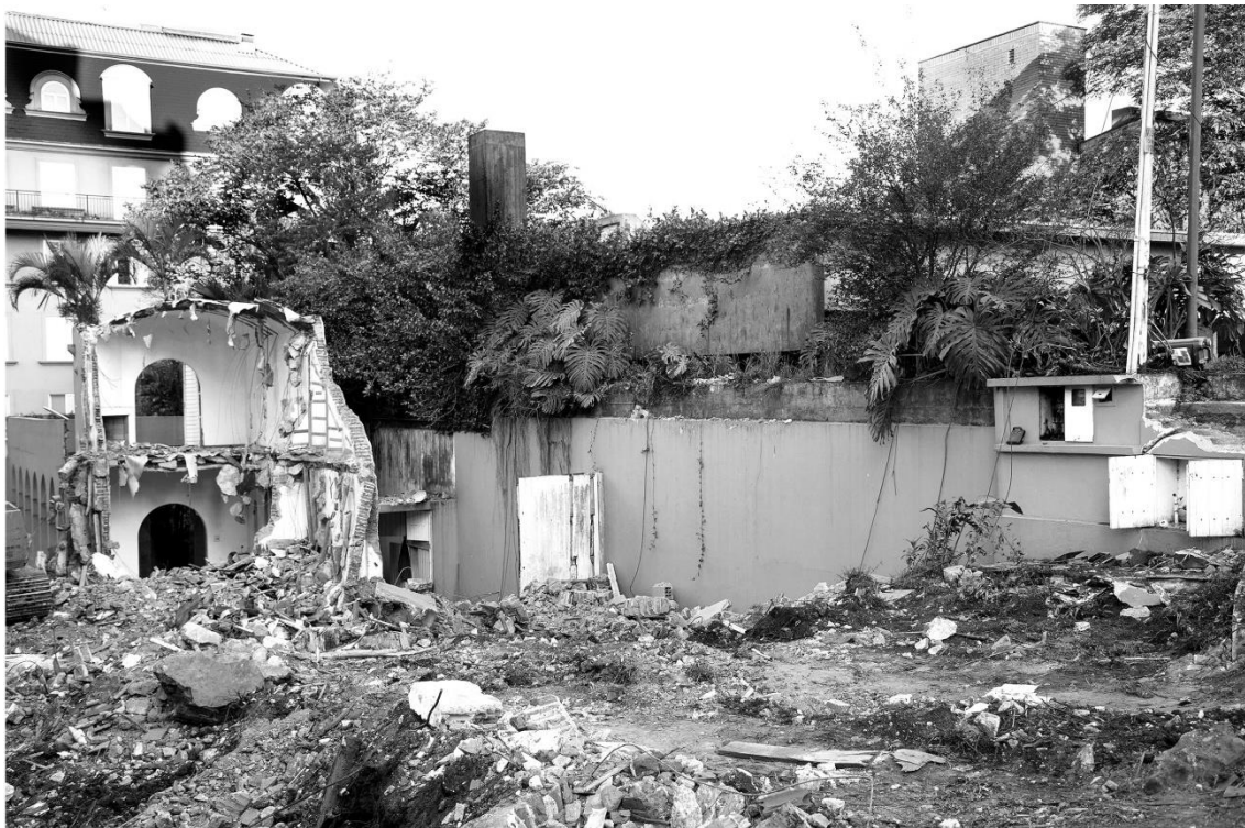
Foto 9. Demolição de construção vizinha à Residência Janne Ottoni. Foto: Ana Ottoni, novembro 2012.
