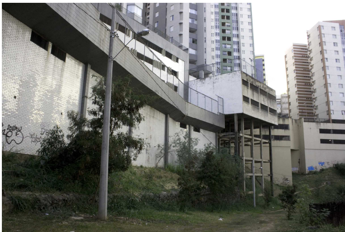
Figura 8: Poste de iluminação e palafitas de um dos prédios que dão as costas para o trecho. Fonte: Arquivo pessoal da autora.
