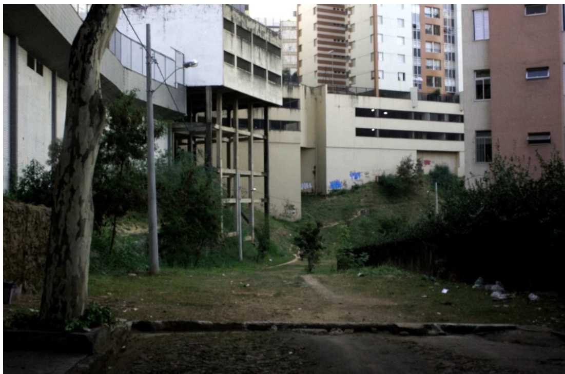
Figura 2: Encontro de uma das partes da Rua Nicarágua com o trecho não urbanizado. Fonte: Arquivo pessoal da autora.
