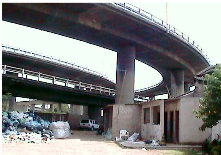
Figura 5: Vista sob o viaduto com os pequenos volumes, galpão do Profetas da Ecologia. Foto Fernando Fuão.
