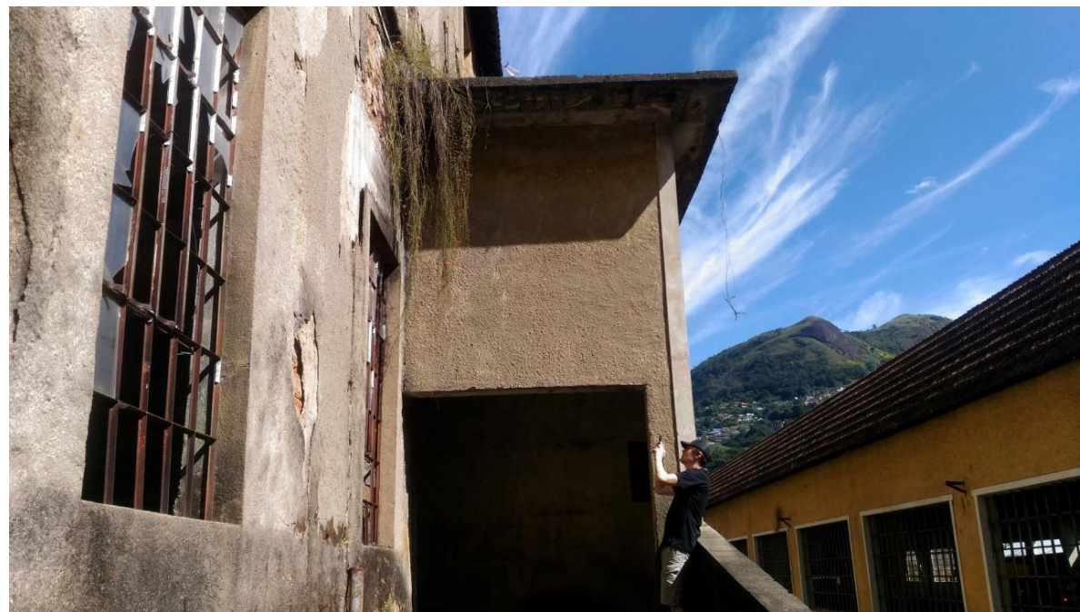
Fig. 5: Cidade "entaberta" na abandonada Fábrica de Papel de Petrópolis/RJ. Fonte: Souza, 2019.
