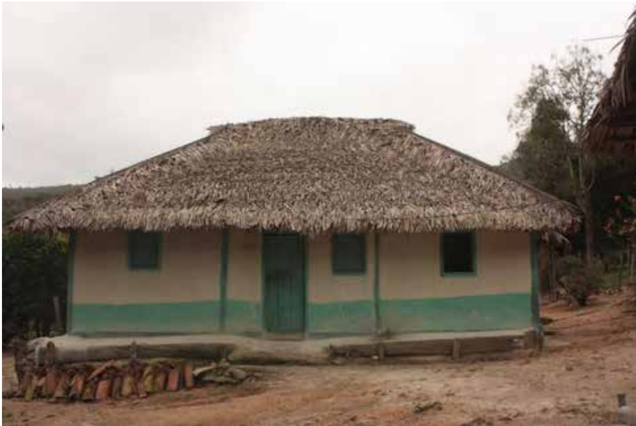
Fig. 4: Fachada de uma das únicas casas com cobertura de palha da comunidade. Fonte: Cerqueira, 2019.
